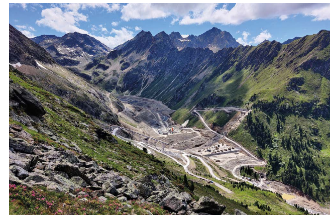
WIKIMEDIA COMMONS | SIMON LEIGNER Arbeitsplatz in den Bergen: Blick auf die Baustelle des Wasserkraftwerks in Kühtai
