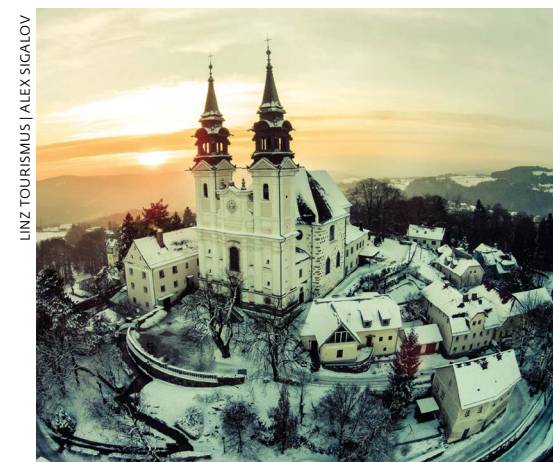
Pöstlingberg im Winter: Die Kirche oben auf der Spitze des Berges wurde im Jahr 1716 erbaut.
